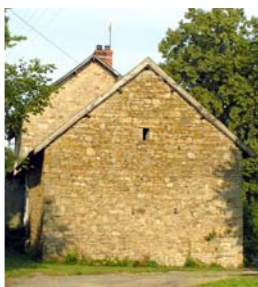
Chanlatte en recouvrement de chevrons - Eymoutiers
